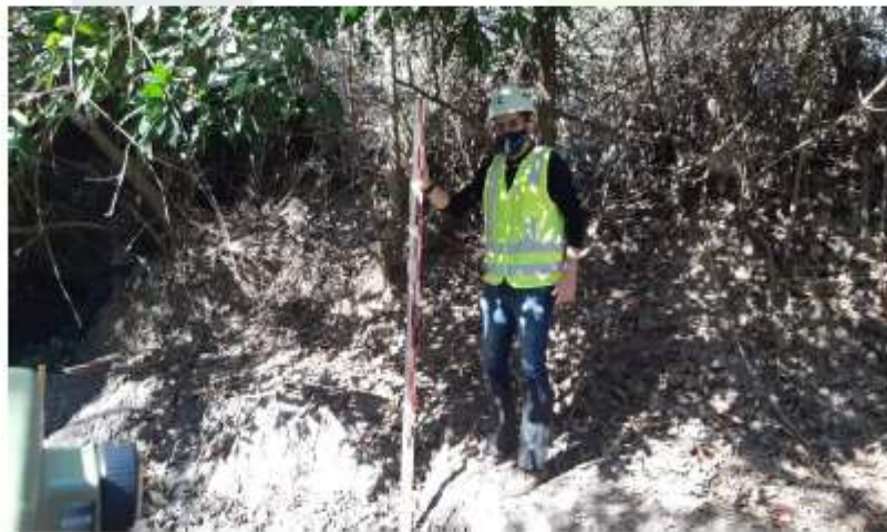
Figura 5: Execução do Nivelamento
