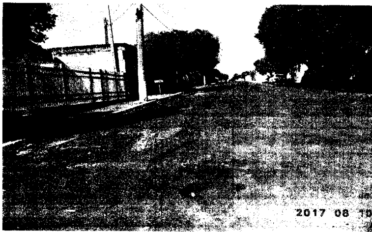
FOTO 01 – RUA BARÃO DO RIO BRANCO
